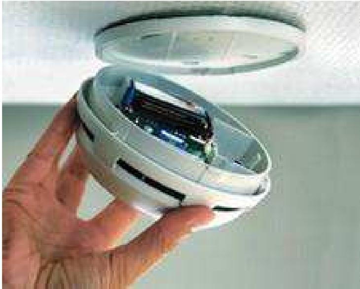
Simplement fixé au plafond sur une platine (2 vis généralement)
