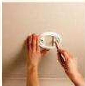
1 Marquez les trous des vis en utilisant la plate-forme de montage.
