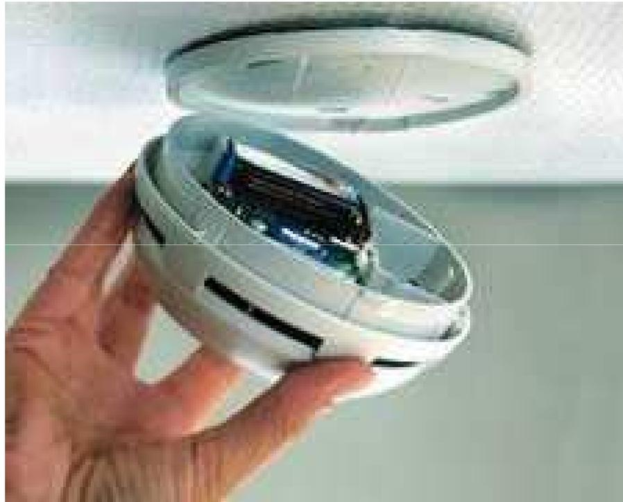
**Changer la pile lorsque la charge devient trop faible**
