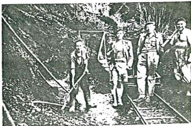
Le minerai, les gros blocs cassés, était débarassé de sa gangue argileuse dans des lavoirs aménagés au plus près de fronts de taille. L'extraction varie de la surface du sol à un maximum d'environ 8 à 10 mètres de profondeur, par taille de 1 m. à 1,50 m. Malgré les renouvellements effectués par les exploitants agricoles à la suite du remembrement, on remarque très bien, au sol, les dépressions de terrain qui indiquent les emplacements d'extraction
